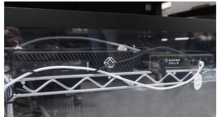
▲報道フロアの操作卓下にあるラック内に設置された、受信機「EMD5104-R」と「EMD2000SE-R」。マルチビュー表示と個別切替操作の双方に対応する運用構成の一部。
